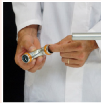
Fig. 3 Contrôle de la présence et du positionnement des joints toriques Checking the presence and positioning of o-rings
