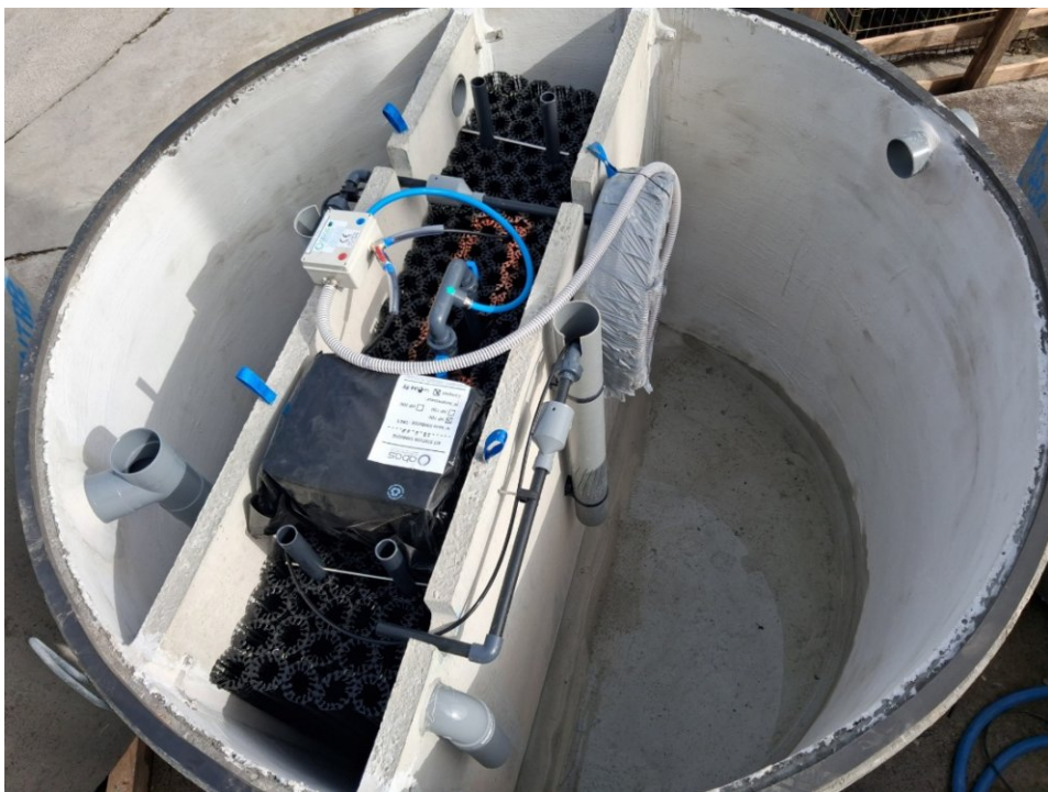
Figure 8 : Vue du dispositif sans son toit
